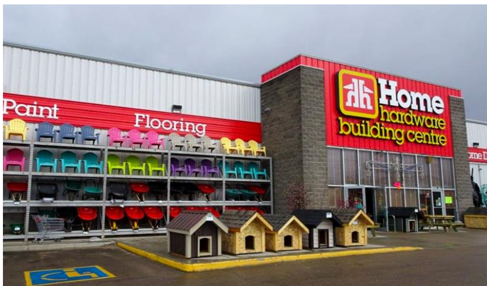
ภาพที่ 2.4 ตัวอย่างรูปแบบหน้าร้านค้าวัสดุก่อสร้างสมัยใหม่
